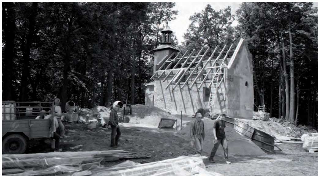
Prace rewitalizacyjne przy kaplicy św. Antoniego w Mąkolnie (lipiec 2013), foto G. Guźlak.
